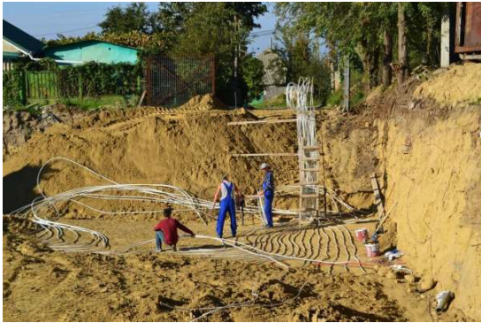
Das Erdregister wird verlegt. Sauber und vorsichtig. Zugedeckt mit Sand und der Erde, die gesiebt wurde.
